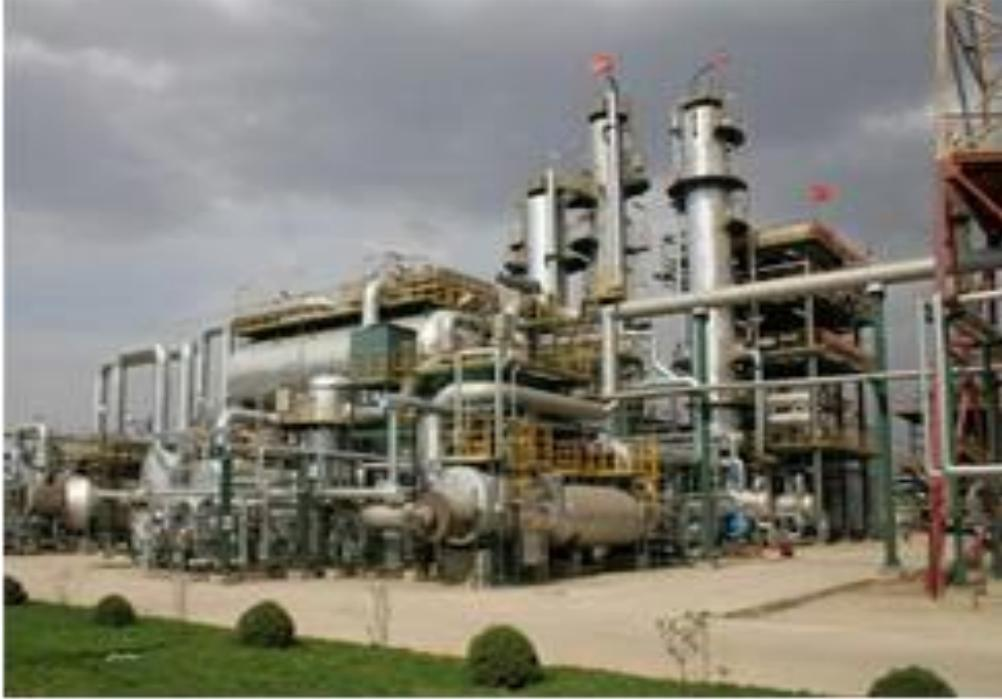
该装置是对炼油过程中产生的含有硫化氢的酸性气，采用适当的工艺方法回收硫磺，实现清洁生产，达到化害为利，变废为宝，降低污染，保护环境的目的，并同时满足产品质量要求，降低腐蚀，实现装置长周期安全生产。
