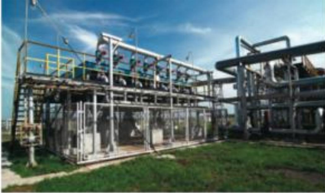
硫回收装置将酸性气体中的硫化氢转化为元素硫。在这些转化过程中，克劳斯（二段脱硫）法是迄今为止最著名的元素硫回收方法，而传统的接触法和 WSA 法是最常用于恢复硫的技术。克劳斯工艺产生的残余气体通常被称为尾气。尾气将被后面的气体处理装置处理。
